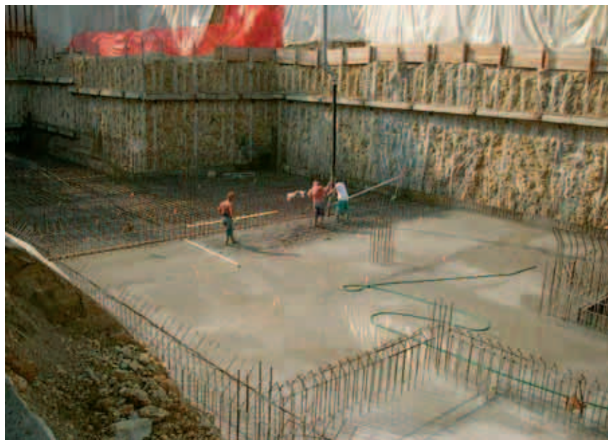
Fasi del getto della platea di fondazione
