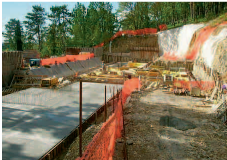
Fasi finali dell'intervento con getto della soletta superiore.
