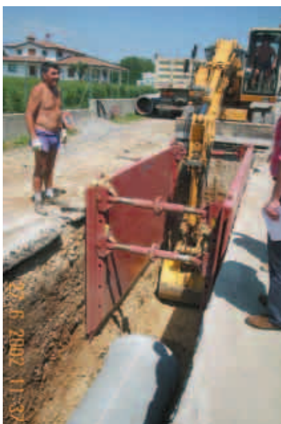
Opere di scavo e posa tubature
