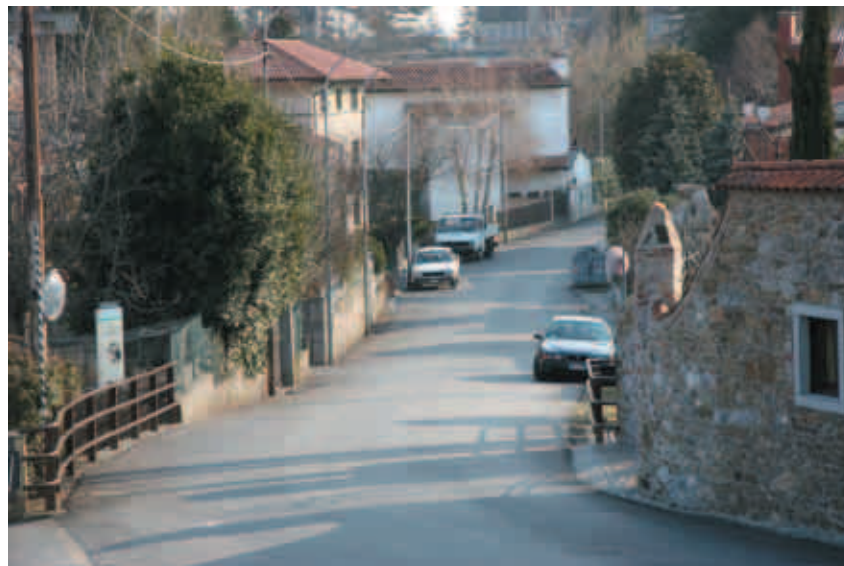
Potenziamento della rete fognaria in un tratto di via S. Moro e successiva riasfaltatura
