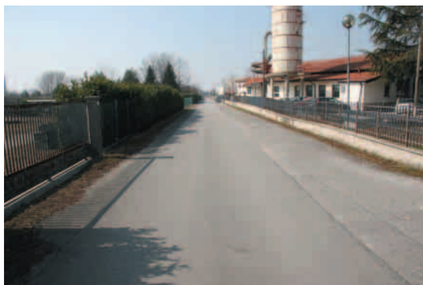
Realizzazione nuova rete fognaria in via Gemona - via Istituto Tecnico Agrario al collettore di via Crognolet e successiva riasfaltatura
