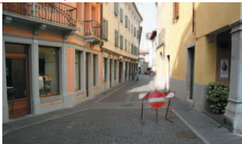
La nuova pavimentazione in via Carlo Alberto
