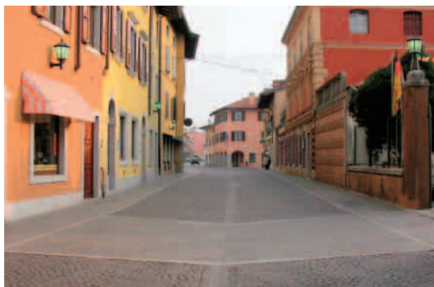
Rifacimento del porfido da borgo di Ponte a piazza Duomo
