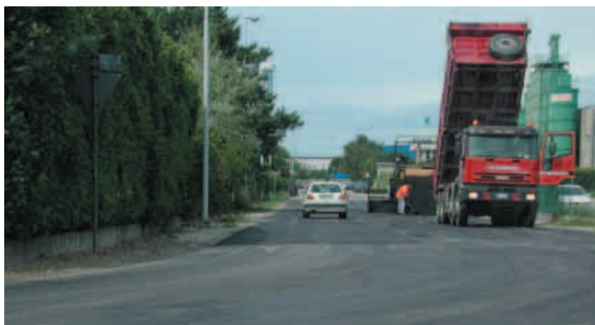
Interventi di asfaltatura nella Zona Industriale
