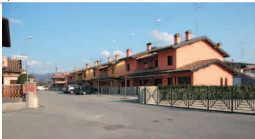
Asfaltatura di via Zuccola
