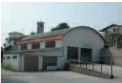
Stato dei luoghi prima dei lavori
