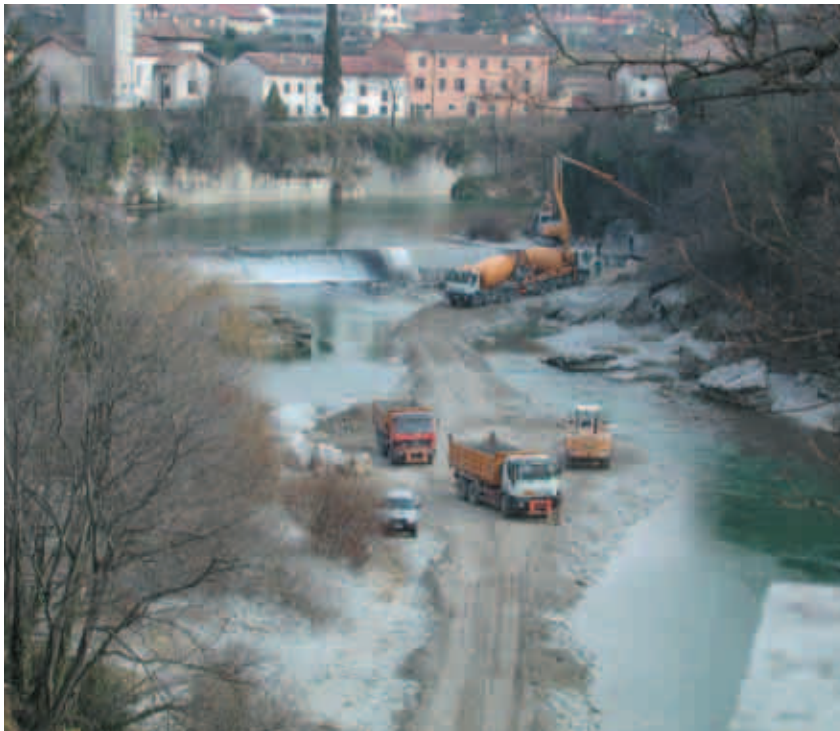
Interventi di messa in sicurezza della briglia a monte del Ponte del Diavolo
