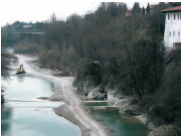
Interventi di sistemazione della briglia a valle del Ponte del Diavolo
