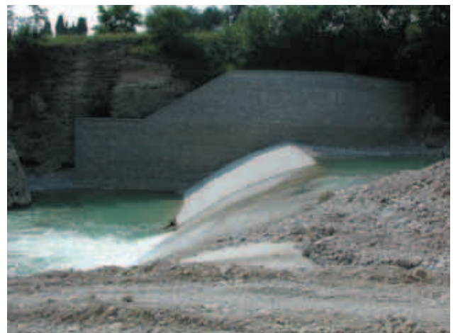
Interventi di sistemazione della briglia a valle del Ponte Nuovo
