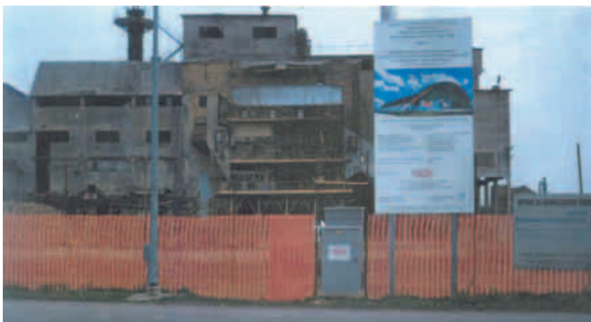
Stato dei luoghi prima dell'intervento: struttura della "Cementi Friuli" (inizio '900)
