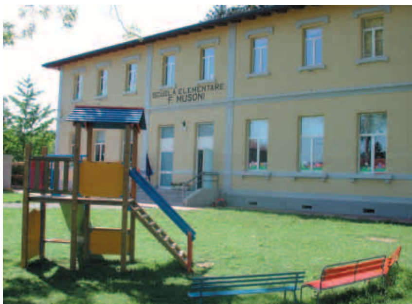
Ristrutturazione della scuola materna di Sanguarzo
