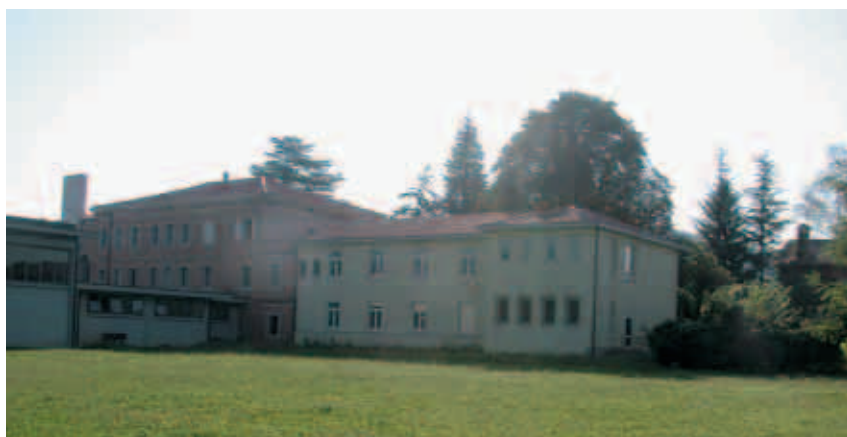
Interventi di ristrutturazione del centro socio riabilitativo e della ex scuola elementare di Carraria
