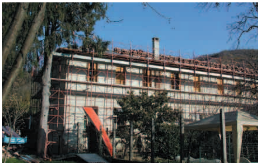
Ristrutturazione della ex scuola di Purgessimo ad uso della frazione
