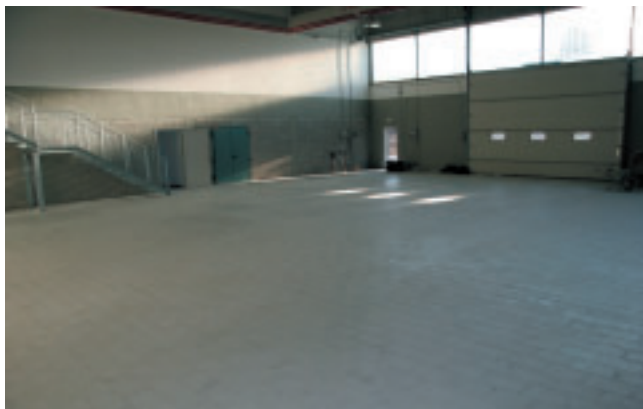
La rimessa per i mezzi al piano terra
