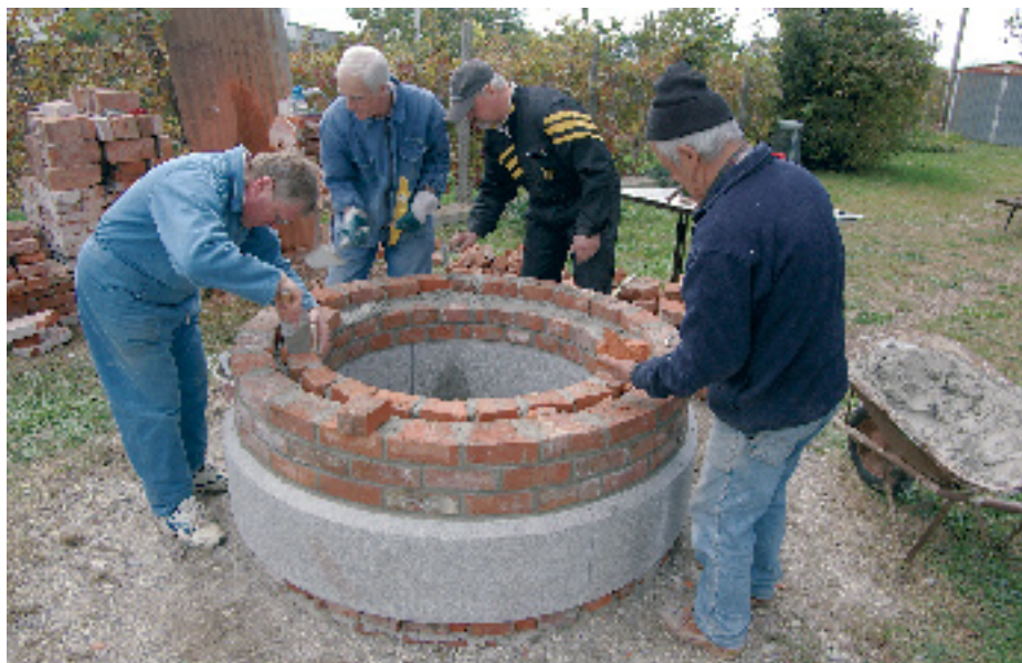
Si lavora alla ricostruzione della vera del pozzo.
