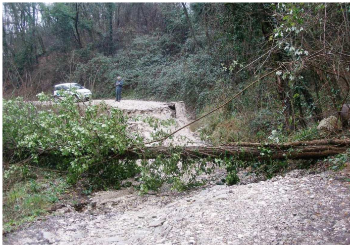
Foto F02: frana 2014 che ha interrotto la strada forestale
